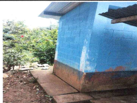
Foto 4: reparacion de banquetas y pintura de baños, por motivo de deteroedo y peligra al momento cuando pasan los niños y darle mejor vista.
