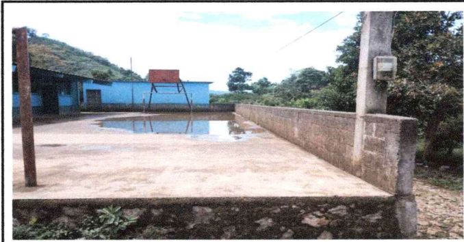
Foto 3: Mantenimiento de muro perimetral de repello con cernido y se le colocara malla encima para mayor seguridad.
