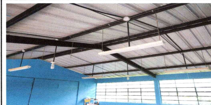
Foto 5: Reparacion de iluminacion del modulo de tres aulas.
