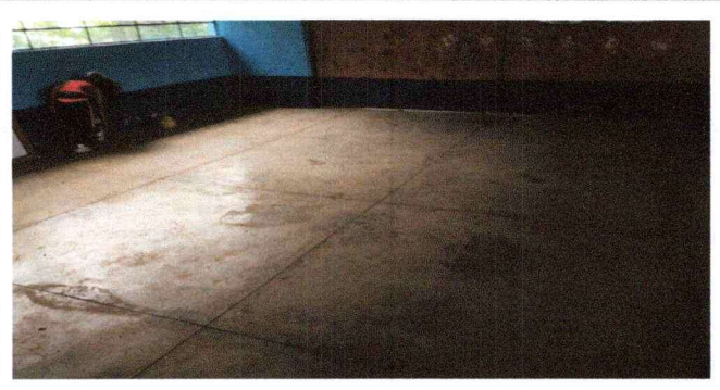
Foto 2: Sustitucion de piso de torta de concreto a piso ceramico, modulo de tres aulas y direccion
