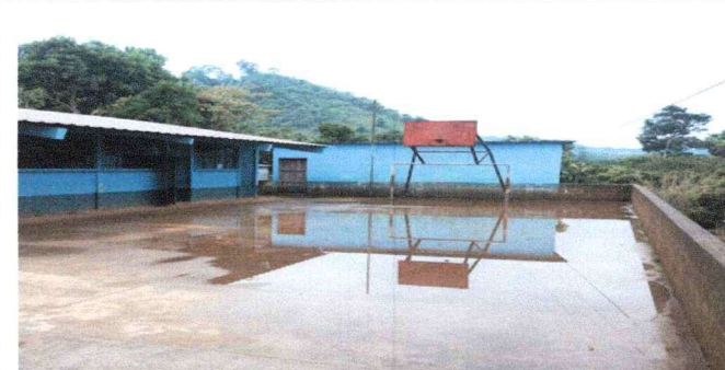
Foto 6: colocacion de rejilla por acumulacion de agua en patio. Cuando llueve siempre se acumula agua por eso queremos evitar enfermedades.
